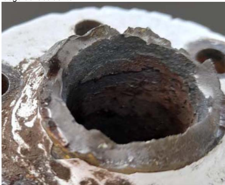
Detalle del interior del eje. Aquí se puede observar la corrosión interior existente, y el nivel de reducción del espesor al que llegó esta parte de la estructura de la pata.
